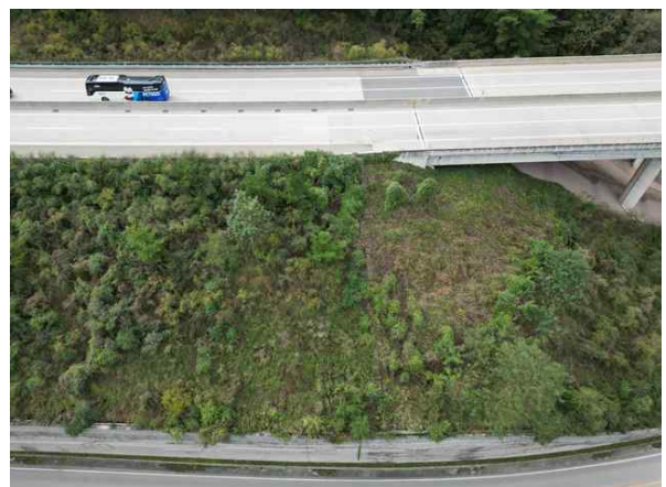
상부 성토부 전경
